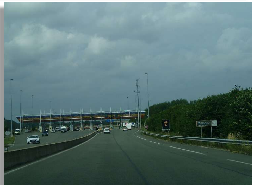
Échangeur A16 Forest-Montiers
