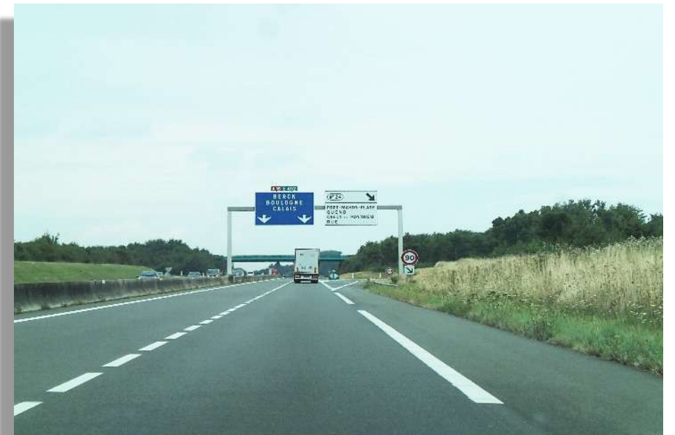
Échangeur autoroutier A16
